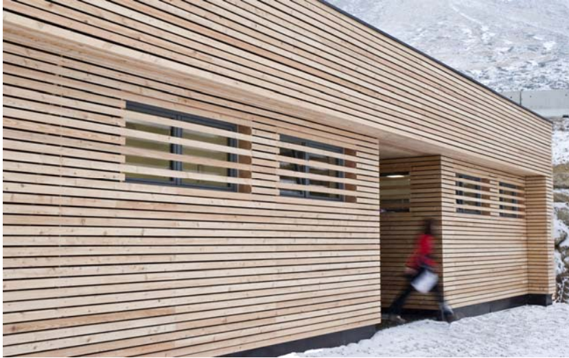
Das Servicegebäude für Camper
